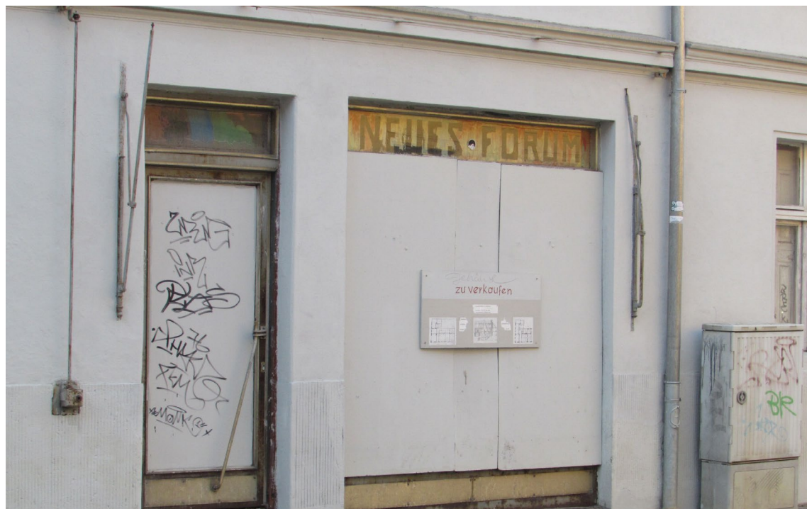
Ehemaliges Büro des Neuen Forums in Brandenburg an der Havel.
